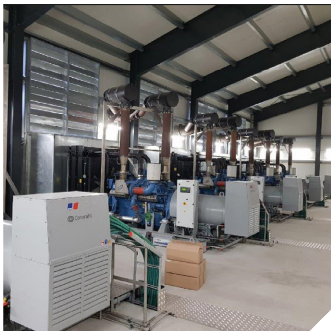
Stationær nødstrømsgenerator
