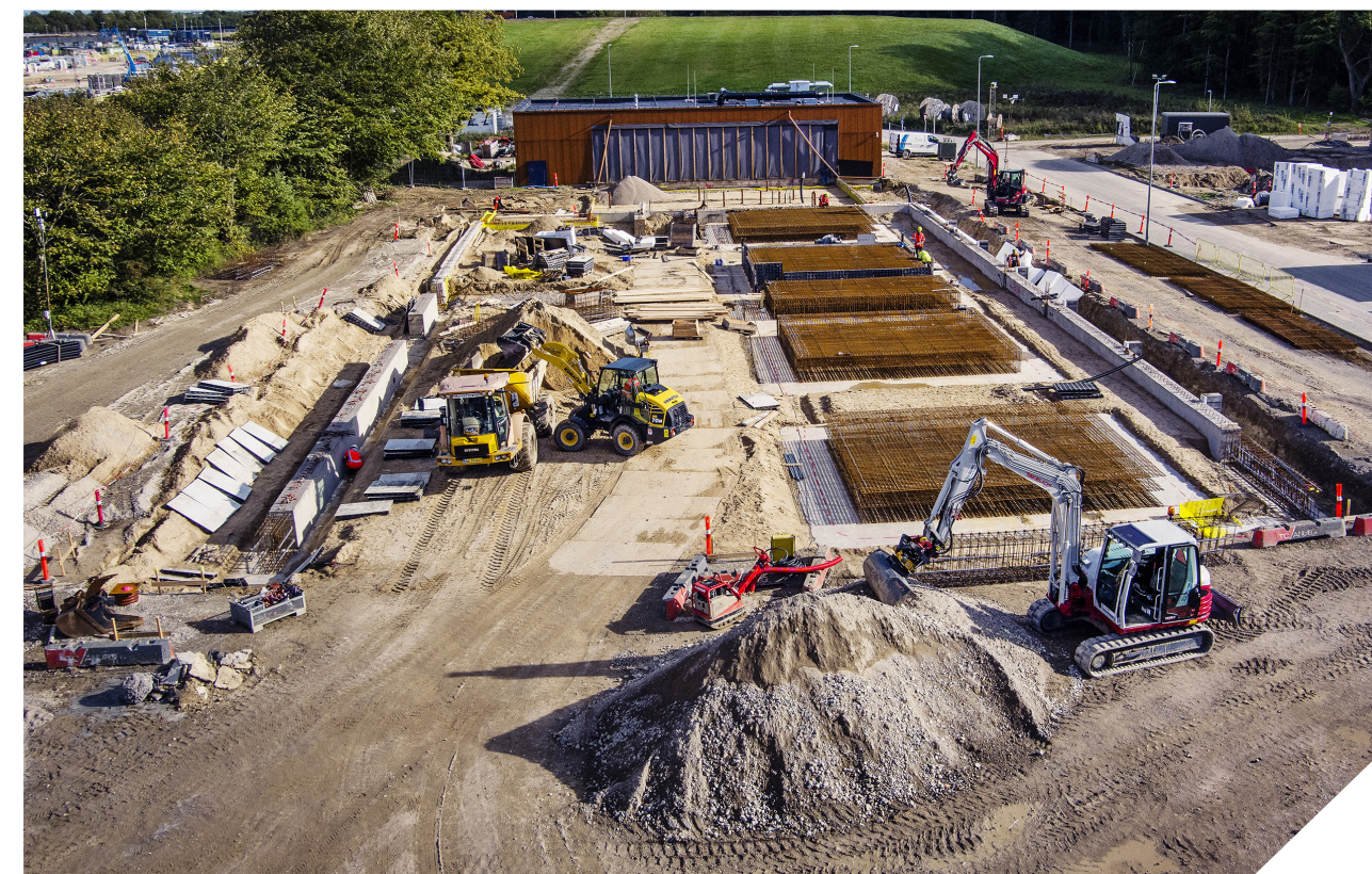
Billede fra byggepladsen, hvor Coromatic opfører et state-of-the-art nødstrømsanlæg for Nyt Odense Universitets Hospital
